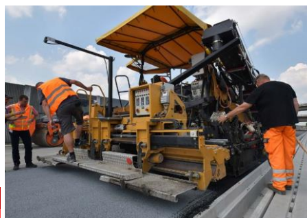
Abbildung 2: Fertigerintegrierter Streuer im Einsatz
