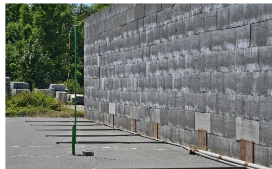
Abbildung 4: Luftmesseinrichtung und Abgasleitungen im Canyon
